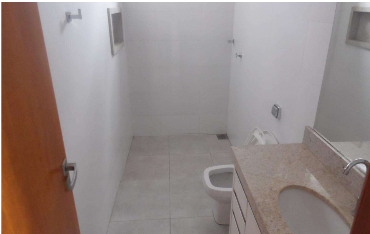
Imagem 15 – Banheiro Social - piso cerâmico, revestimentos até o teto, instalações elétricas e hidráulicas embutidas, Louças e Metais sanitários de boa qualidade, em boas condições.
