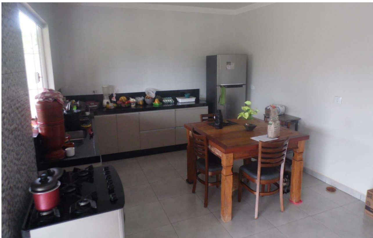
Imagem 10 – Copa/Cozinha - piso cerâmico, Laje, instalações elétricas e hidráulicas embutidas, Esquadria em metal e pintura em Látex sobre reboco, ambiente em bom estado e sem danos.
