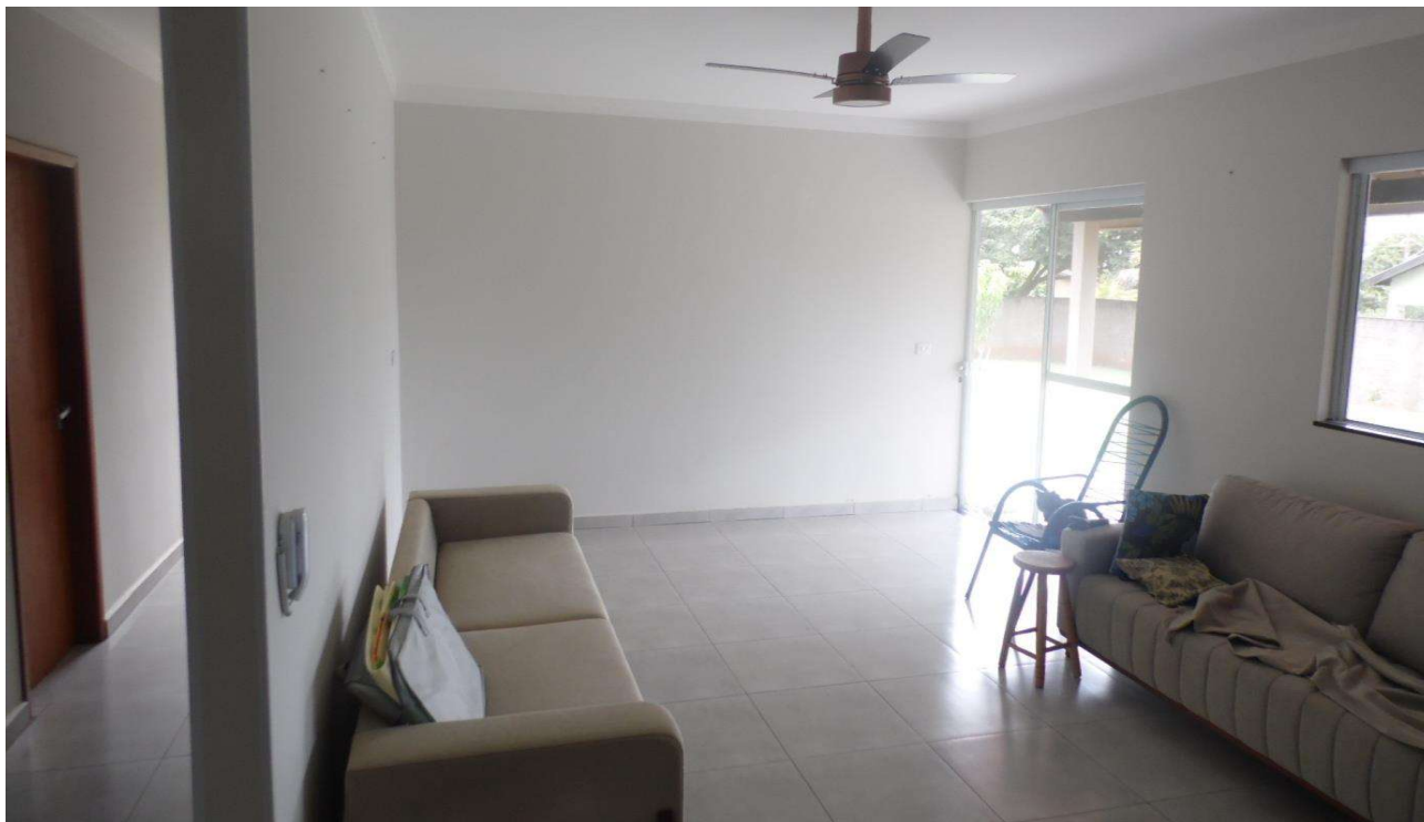
Imagem 09 – Interior da residência principal, Sala de Estar - piso cerâmico, Laje, Esquadrias em metal, instalação elétrica embutida e pintura em Látex sobre reboco, em boas condições.
