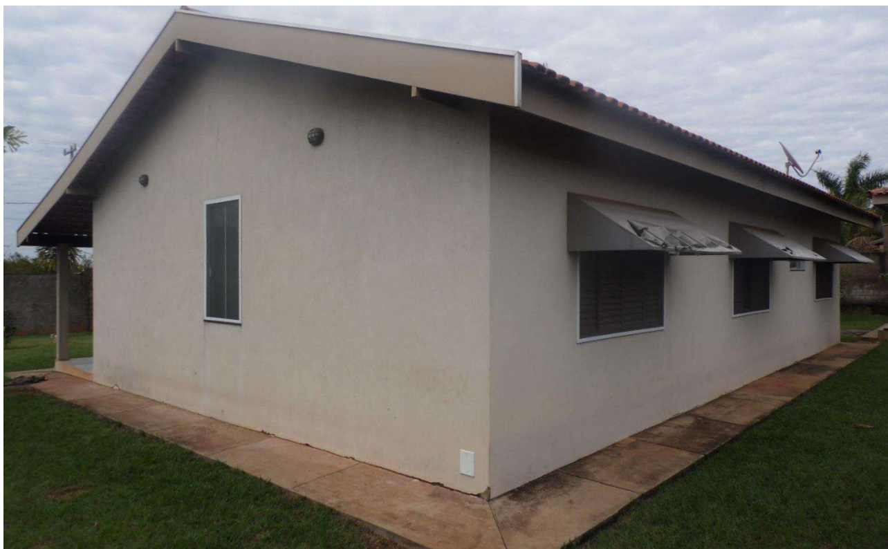
Imagem 08 – Residência principal - construção em alvenaria com Laje, cobertura em telhas de barro sobre estrutura em madeira, Esquadrias em metal e a pintura é em Látex sobre reboco.
