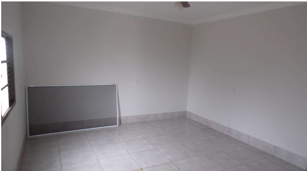
Imagem 19 – Dormitório do Anexo para hóspede - piso cerâmico, Laje, Esquadria em metal, instalação elétrica embutida, pintura em Látex sobre reboco, em boas condições e sem danos.
