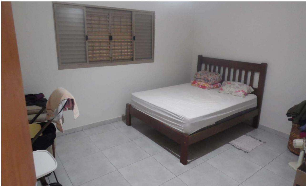
Imagem 13 – Suíte residência principal - piso cerâmico, Esquadria em metal, instalação elétrica embutida, pintura em Látex sobre reboco, imóvel em bom estado de conservação/manutenção.
