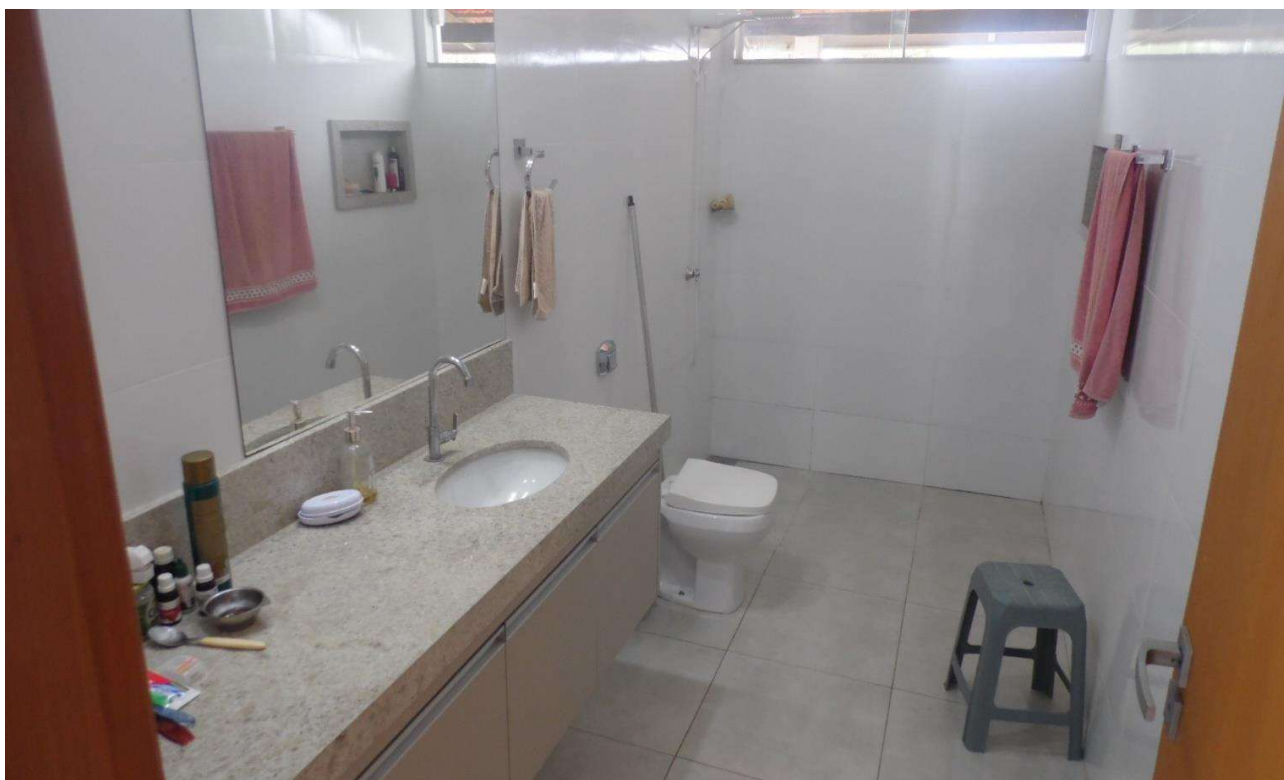
Imagem 14 – Banheiro da Suíte - piso cerâmico, revestimentos até o teto, porta laminada, instalações elétricas e hidráulicas embutidas, Louças e Metais sanitários de boa qualidade.
