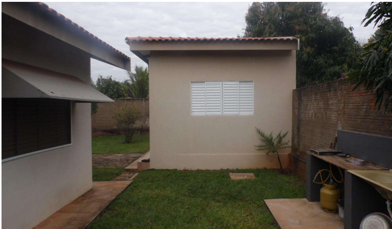
Imagem 17 – Anexo para hóspede - também construído em alvenaria, Laje, cobertura em telhas de barro sobre estrutura em madeira, Esquadrias em metal e pintura em Látex sobre reboco.
