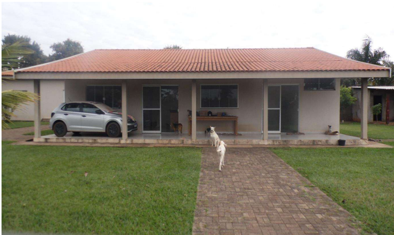
Imagem 07 – Residência principal - edificação com 03 Dormitórios, sendo 01 Suíte, Sala de Estar, Copa/Cozinha, Banheiro Social e Varanda, com área total construída de 151.50 m2.
