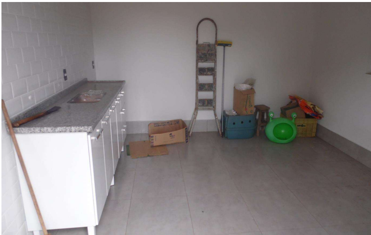
Imagem 18 – Cozinha do Anexo para hóspede - piso cerâmico, Laje, revestimento cerâmico em uma parede, instalações elétricas e hidráulicas embutidas e pintura em Látex sobre reboco.
