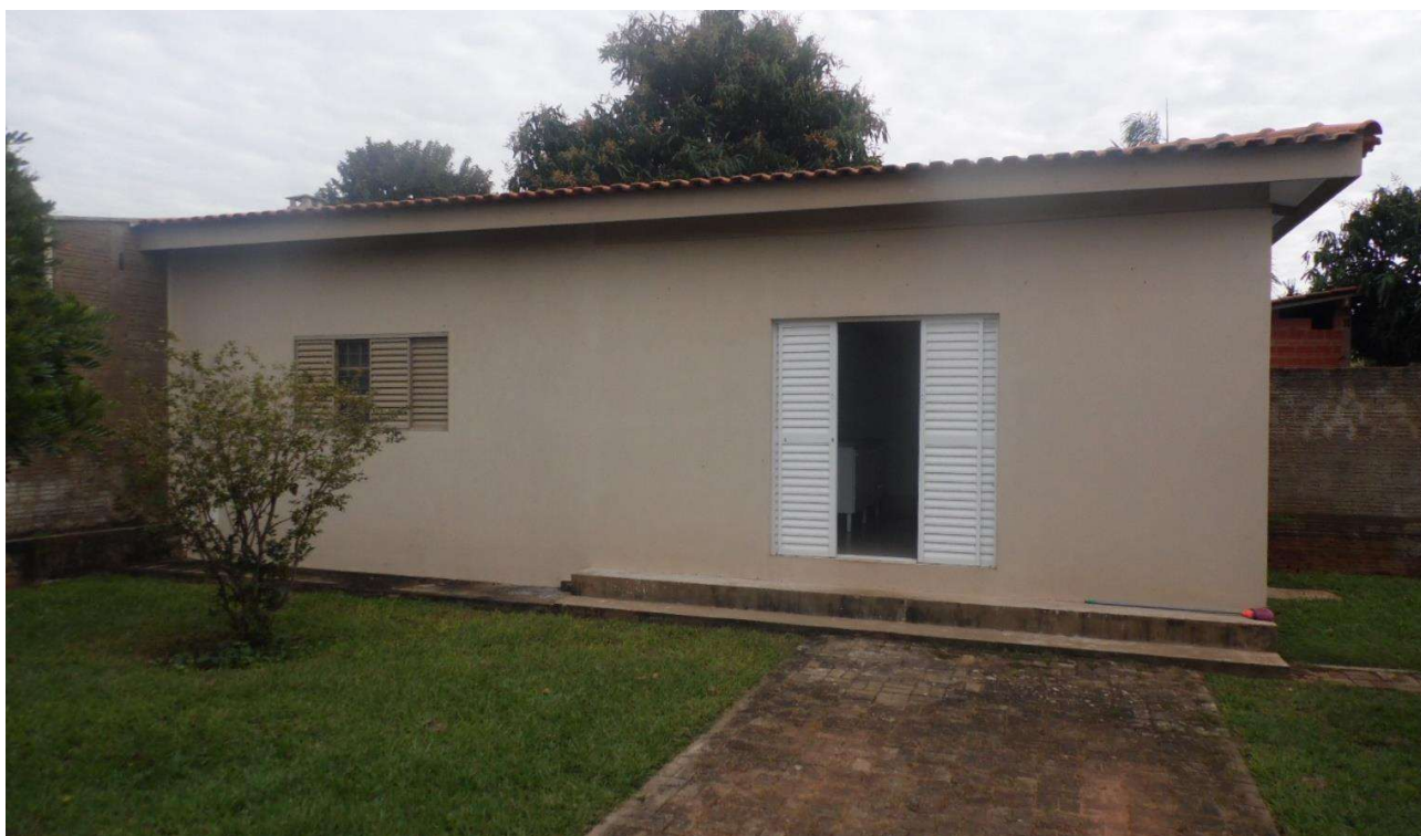
Imagem 16 – Anexo para hóspede - edificação com 01 Dormitório, Cozinha e Banheiro, com área total construída de 42.50 m2 e com padrão construtivo similar ao da residência principal.
