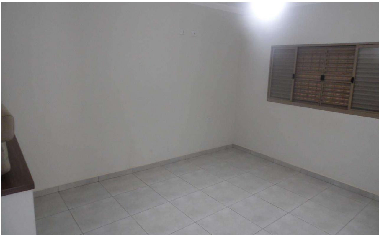
Imagem 11 – Um dos Dormitórios da residência principal - piso cerâmico, Laje, Esquadria em metal, instalação elétrica embutida e pintura em Látex sobre reboco, ambiente em bom estado.
