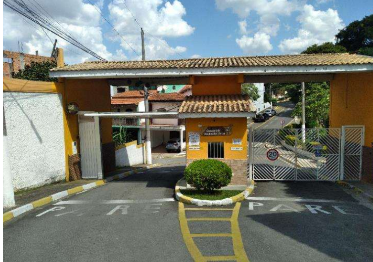
Foto 01 – Portaria do Condomínio
