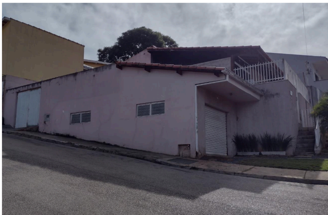
Foto 3: Fachada do Imóvel para a rua Geralda de Paula Mendonça
