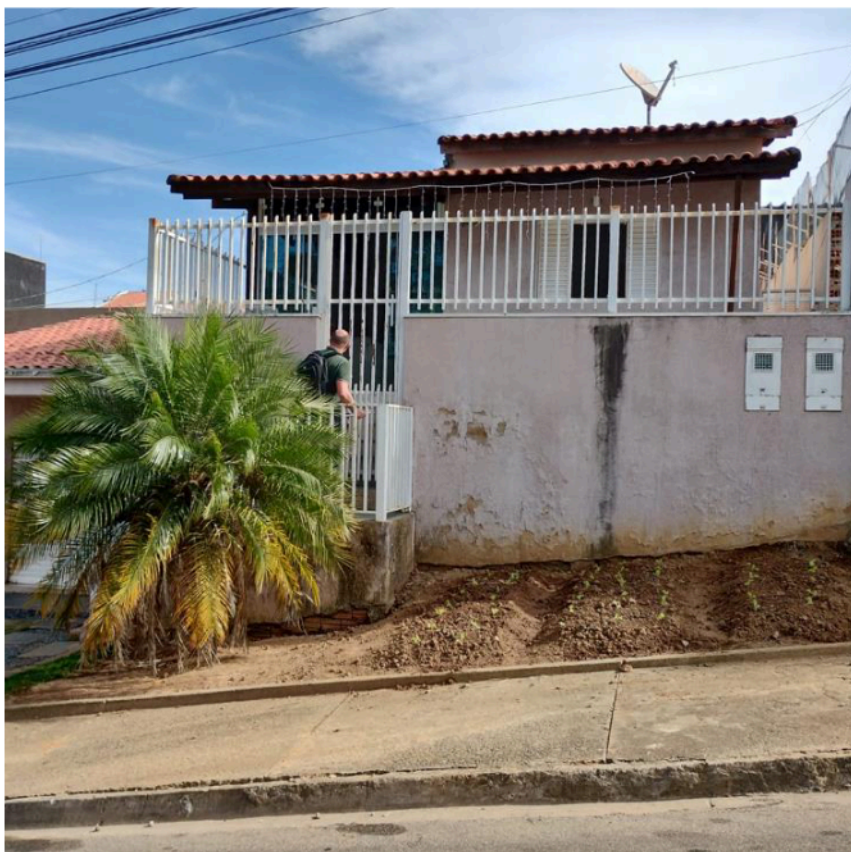
Foto 2: Fachada do Imóvel para a rua José Freitas, 245
