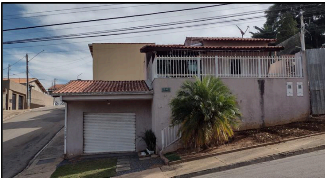
Foto 1: Imóvel à rua José Freitas, 245 - Vila Piedade
